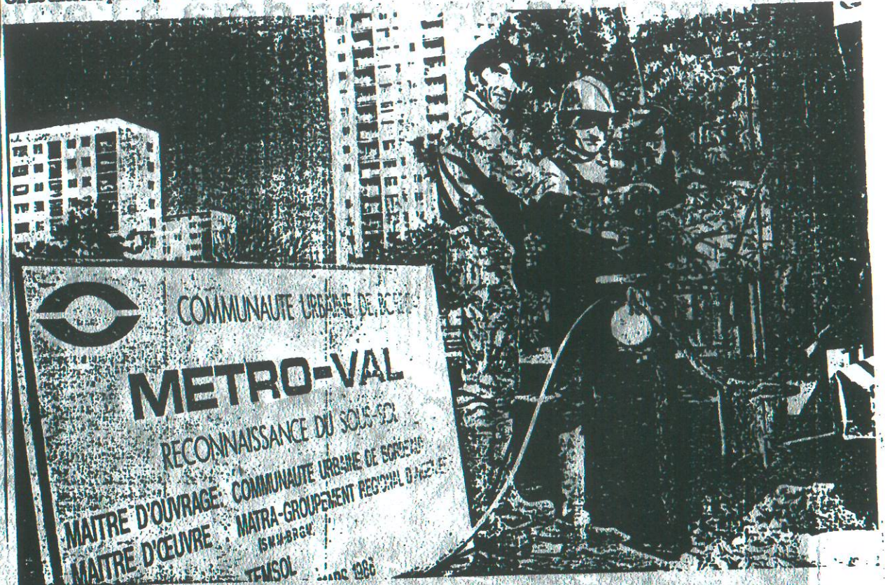
Forage au Grand-Parc (Photo Michel André, « Sud-Ouest »)
